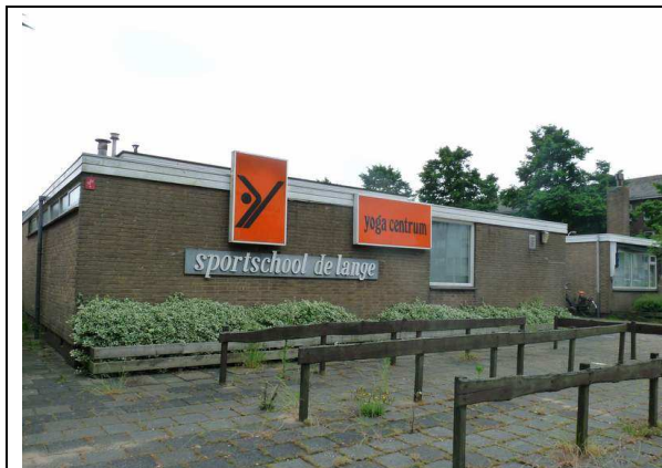
Fig. 3, Vooraanzicht van de sportschool. De foto is genomen vanaf de Wijk aan Duinderweg richting het zuiden.
